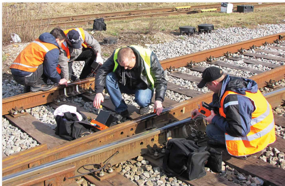
С помощью переносных ультразвуковых дефектоскопов проверяется качество термитной сварки рельсов в пути
